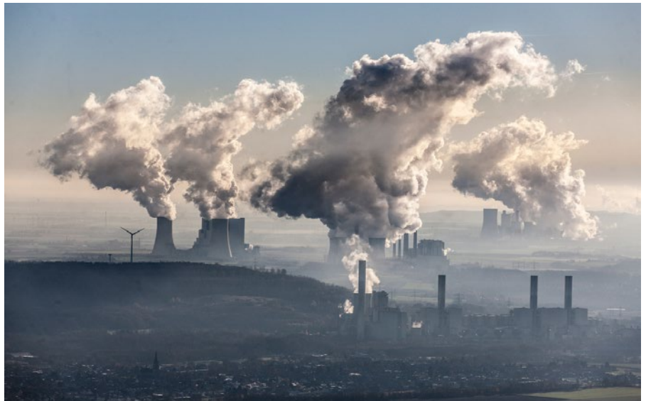
Luftaufnahme der Kohlekraftwerke Neurath und Niederaussem
