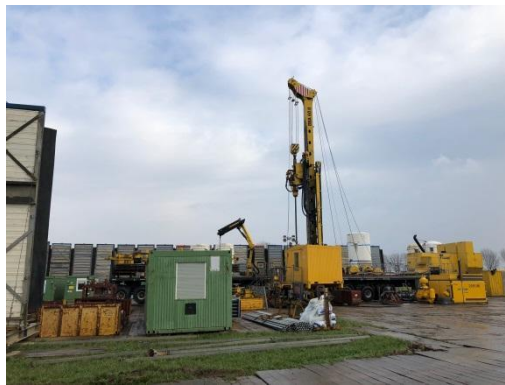
Bau einer RWE-Grundwasserpumpe in Oberwestrich (21.2.19)
