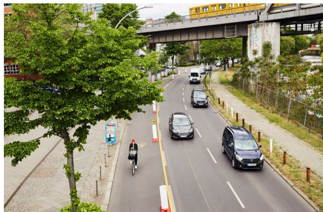
Mit Baken, Piktogrammen und einer gelben Linie wird diese Fahrspur in Berlin für den Radverkehr reserviert.
